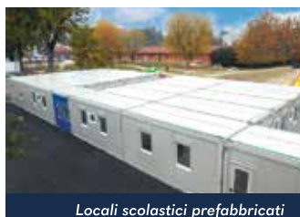
Locali scolastici prefabbricati
