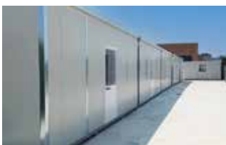
Dormitori da cantiere
