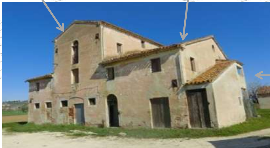
Edifici di nuova costruzione e ristrutturazioni
